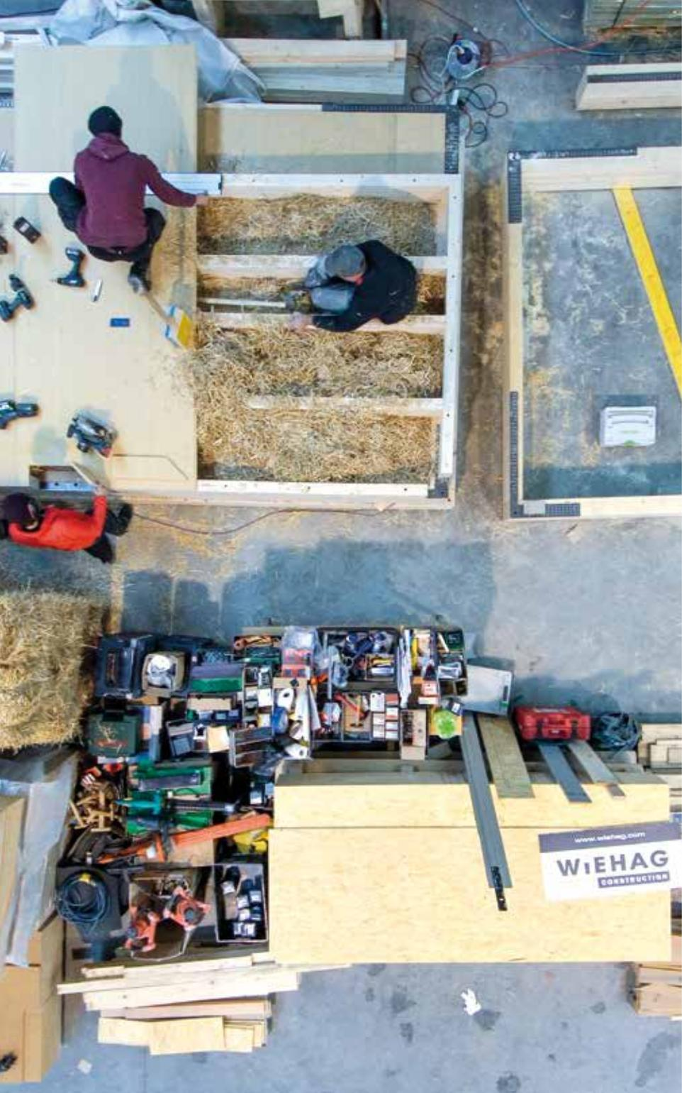
**Im Rahmen der vivihouse-Bauworkshops kamen neben Deckenkran und Gabelstapler zum Manövrieren der schweren Bauelemente innerhalb der Produktionshalle vor allem folgende Werkzeuge zum Einsatz:** Akkuschrauber, Hammer, Kapp- und Tauchsäge, Luftdrucktacker, Zwangsmischer sowie Kellen zum Verputzen. Außerdem noch Spezialwerkzeuge zum Stopfen und Verdichten von Strohballen, die zumeist während der Bauworkshops selbst hergestellt wurden.
